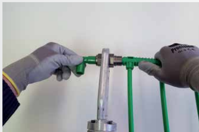
Krok 2 Elementy nałożyć na zgrzewarkę i przetrzymać przez 4-5 sekund.
