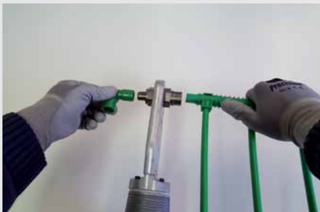
Krok 1 Elementy nałożyć na zgrzewarkę.
