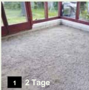
Vorbereitung des Untergrundes
