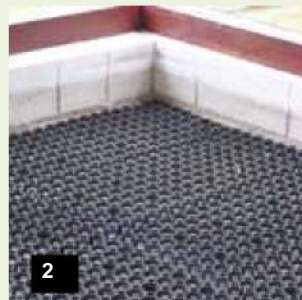
Ausbringen der Armierungsgitter
