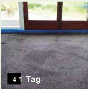
Einbau ThermoDyn Unterkonstruktion
