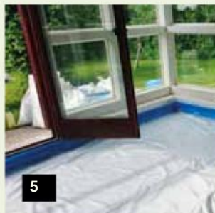
Einbau Dampfsperre
