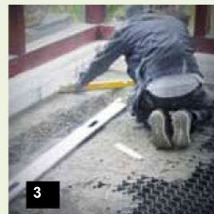
3 Installation de la sous-structure Ther
