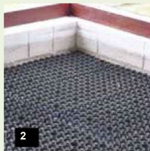
2 Déploiement des grilles de renforcement
