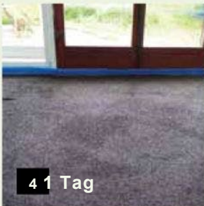
4 1 Tag Installation de la sous-structure ThermoDyn
