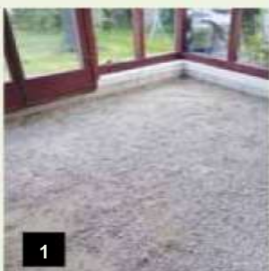
1 Preparazione del substrato
