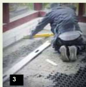
3 Installazione della sottostruttura ThermoDyn
