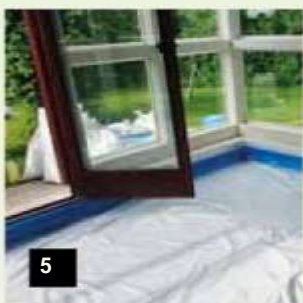
5 Installazione della barriera al vapore
