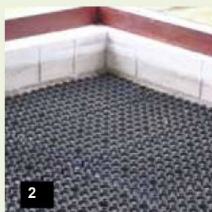
Montaż siatki wzmacniającej
