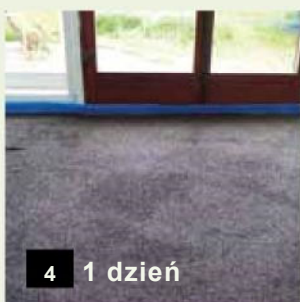
Przygotowanie podbudowy ThermoDyn
