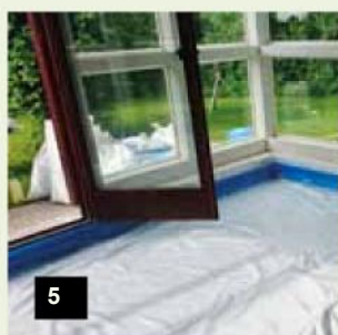
Montaż folii paroizolacyjnej
